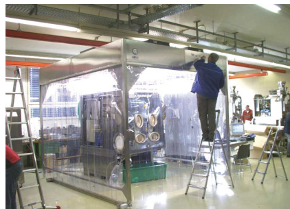
Reinraumkabine aus Edelstahl, Klasse A mit VeFiMos
